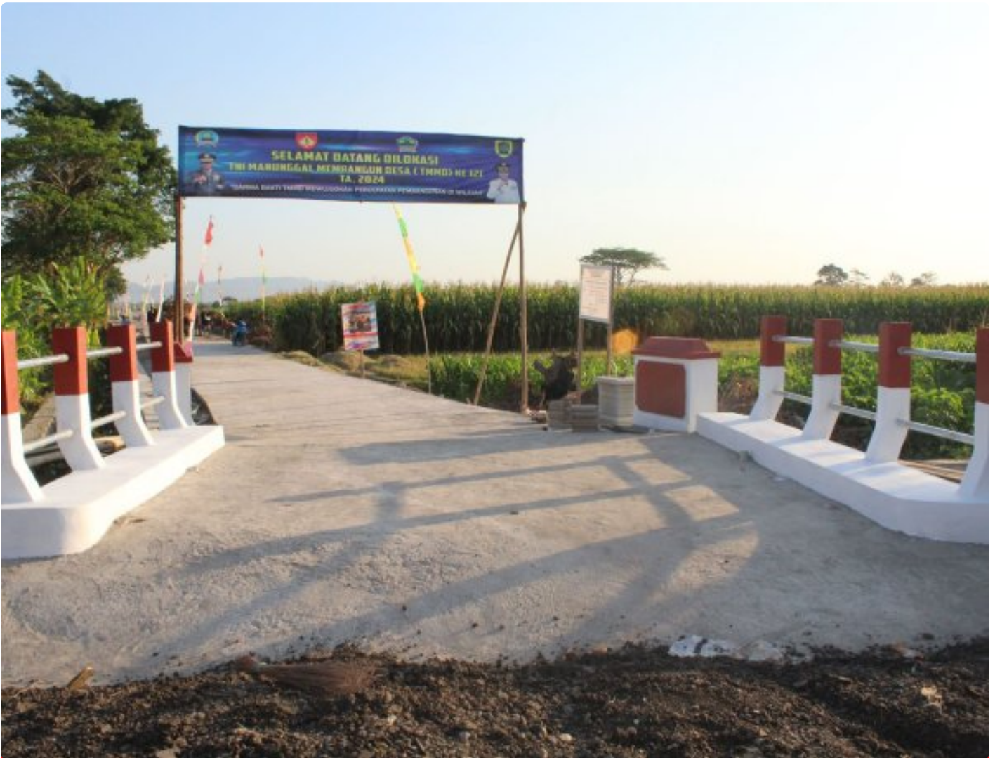
Dandim Klaten Berharap Warga Merawat Jembatan TMMD
